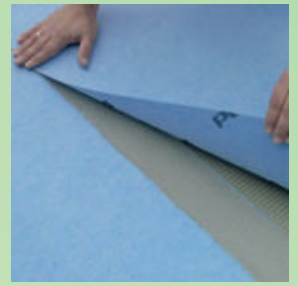
Kiinnitä matto paikoilleen massan avoimena aikana.
