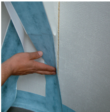
Poista suojakalvo ja paina PCI Pecitape WS alustaan venyttämättä nauhaa.
