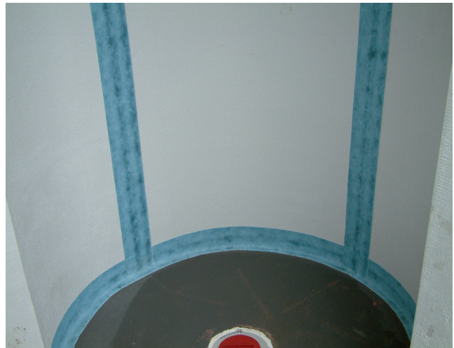
PCI Pecitape WS voidaan asentaa nopeasti ja luotettavasti myös geometrisesti hankaliin muotoihin (tässä pyöreä suihku).
